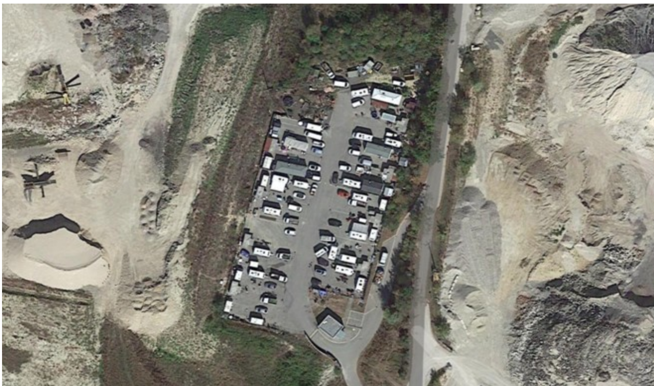
Aire d'accueil de Gex (01), située à l'écart de la ville, entre deux sites de carrières et d'enfouissement de déchet © google maps
